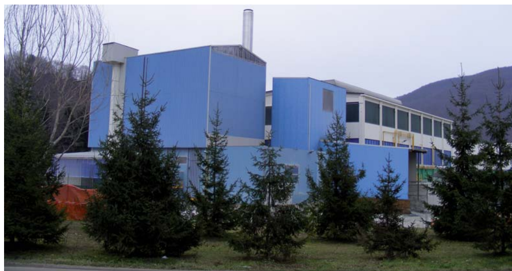
Lo stabilimento di Vetreria Etrusca ad Altare. In alto, linee produttive e magazzino prodotti finiti
