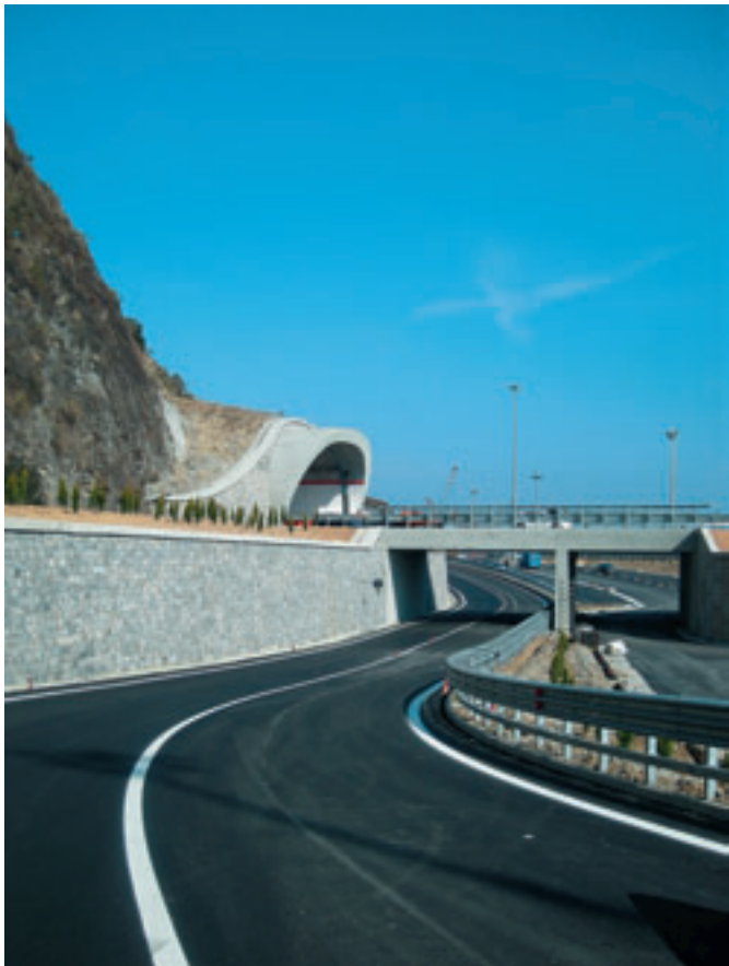
Sopra, lo svincolo di Capo Vado dell'Aurelia bis che consente di distribuire sia il traffico diretto o proveniente dalla Riviera, sia quello portuale
