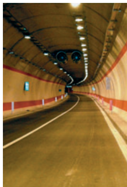
La galleria sotto il promontorio di Capo Vado, lunga quasi 1,5 km, mette in collegamento diretto la strada litoranea con gli svincoli autostradali di Savona
